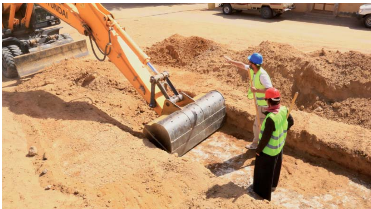
DIAGNOSTIQUE À LA PELLE MÉCANIQUE DU SECTEUR DÉVASTÉ DE LA NÉCROPOLE ANTIQUE
